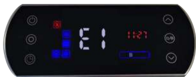
Пример отображения ошибки на панели управления котла
