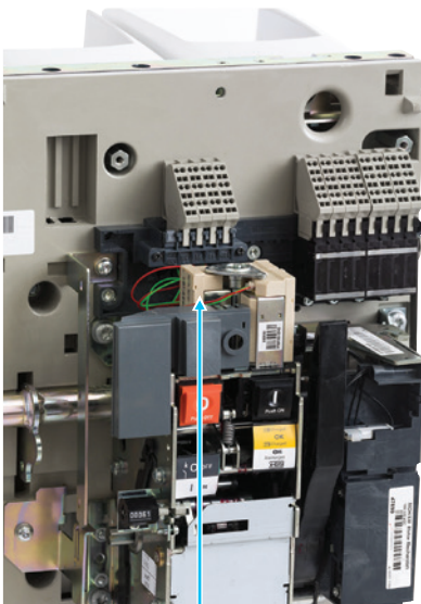
Катушка отключения MX2 или катушка минимального напряжения MN
