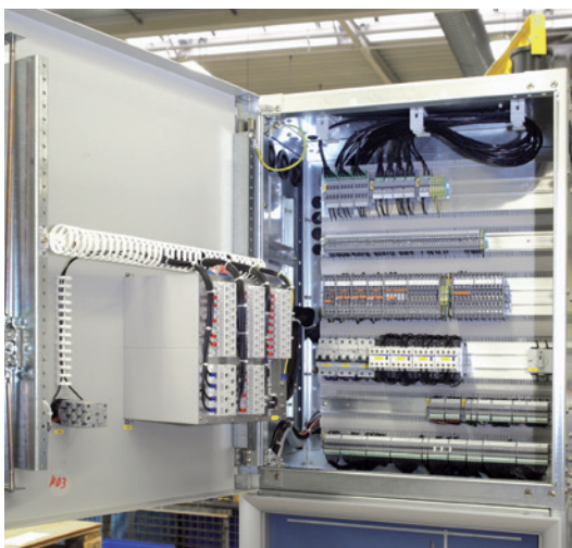
Низковольтный отсек
