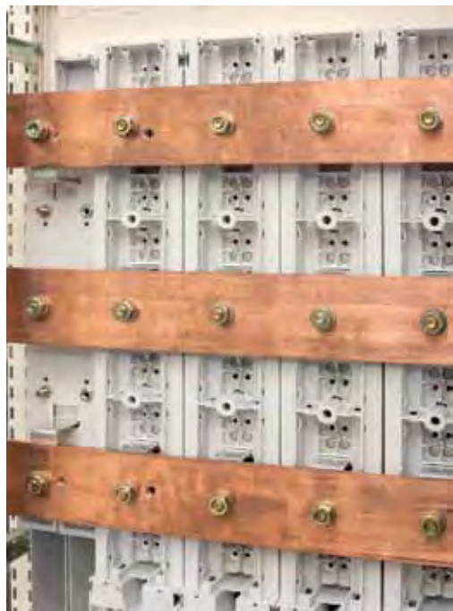
ISFL160 (прямое присоединение к распределительным шинам)
