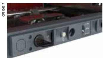
Блокировка в положении «выкачено» с помощью встроенного замка
