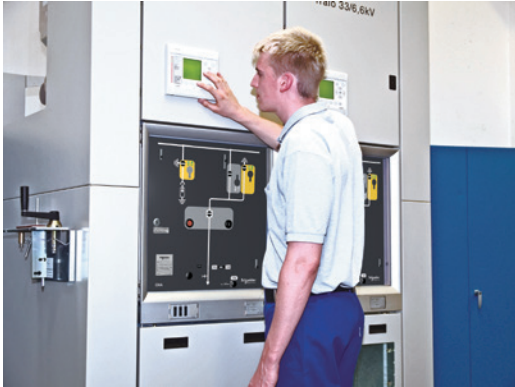
Распределительное устройство с одинарной системой сборных шин
