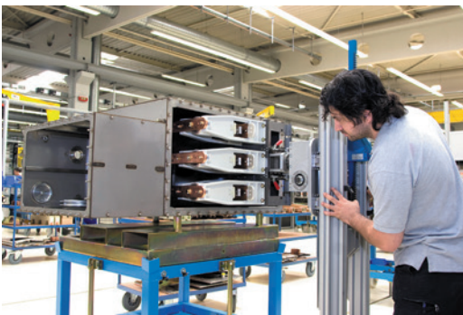
Монтаж силового выключателя
