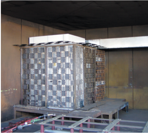
Конструкция для испытания на стойкость к воздействию внутренней дуги с индикаторами
