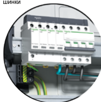
УЗИП iPRD 4P + iC60N 4P
