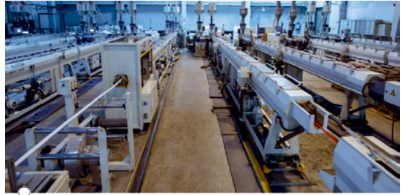
Крупнейший в России трубный цех по производству полипропиленовых и полиэтиленовых труб для систем отопления, водоснабжения
