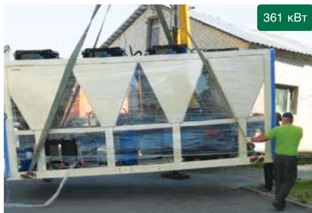
НВП «АСТРАФАРМ», БАЛАШИХА чиллер воздушного охлаждения
