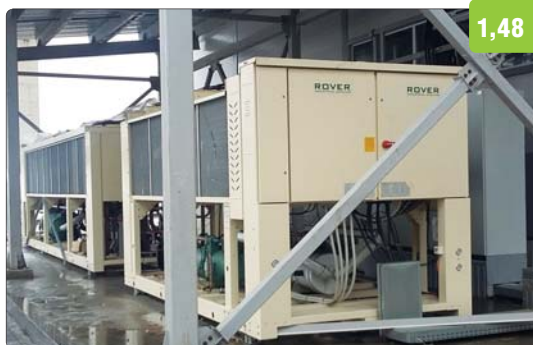
ЗАВОД «РОЛЛ АГРО», ДЗЕРЖИНСК чиллеры воздушного охлаждения с винтовым компрессором
