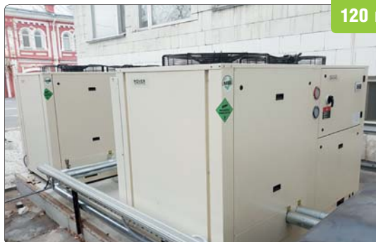
ЦОД ПРАВИТЕЛЬСТВА САРАТОВСКОЙ ОБЛАСТИ, САРАТОВ чиллер воздушного охлаждения со спиральным компрессором
