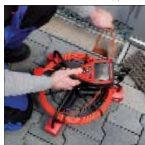
Обследование ливневых труб
