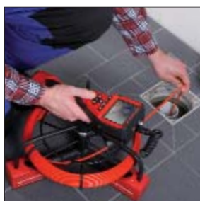
Обследование водостоков
