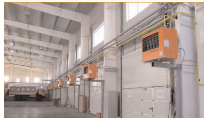
ОАО "СаратовГазАвтоматика" Производство
