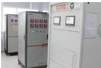
Испытания под давлением
