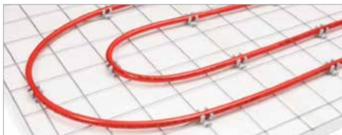
Крепление труб на арматурной сетке
