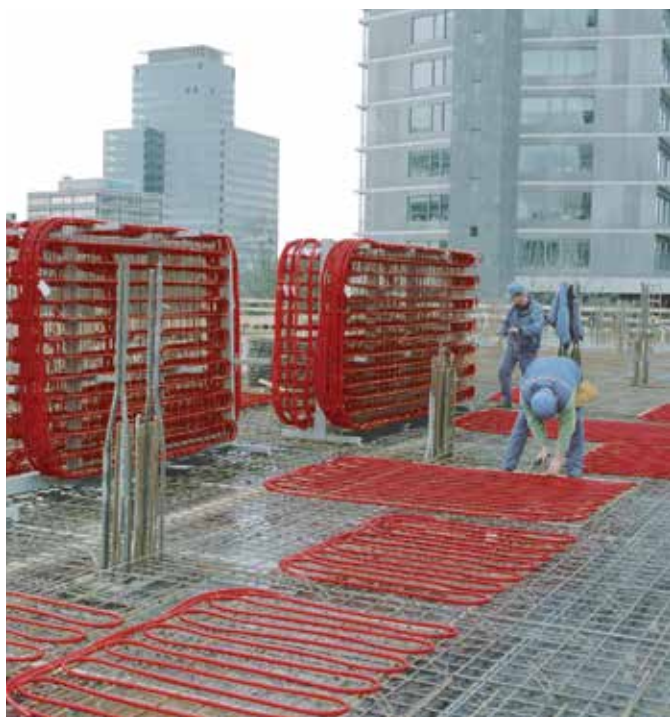
Подогрев и охлаждение ядра бетонных перекрытий
