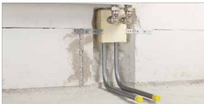
Присоединительный блок RAUTITAN для подключения отопительного прибора
