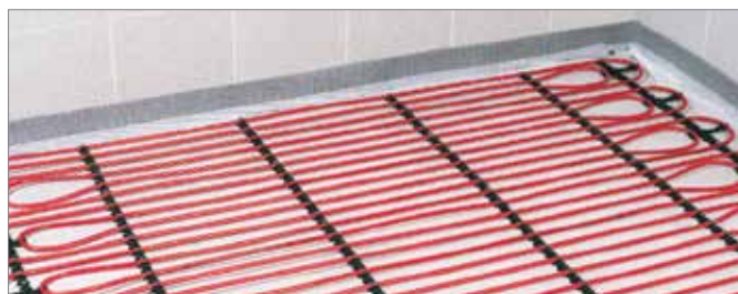
Система напольного отопления/охлаждения («мокрый» способ укладки труб)
