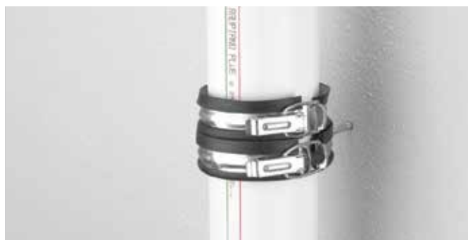
Запатентованная техника крепления RAUPIANO Plus к стене
