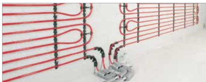
Система настенного отопления/охлаждения («мокрый» способ укладки труб)
