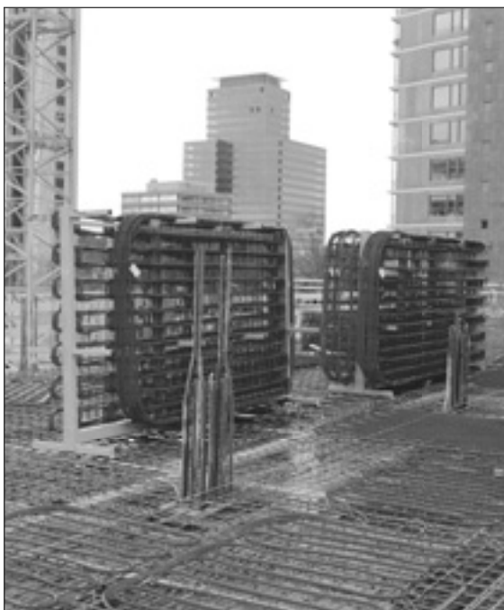
Подогрев и охлаждение ядра бетонных перекрытий
