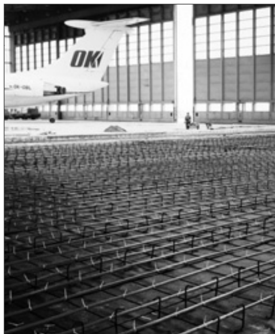
Напольное отопление для промышленных зданий
