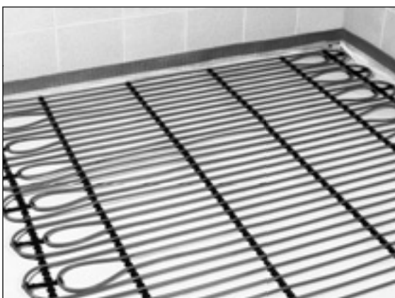
Система напольного отопления/охлаждения («мокрый» способ укладки труб)
