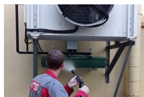
Монтаж и шефмонтаж
