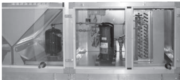
Рис. 16. Встроенный компрессорно-конденсаторный блок
