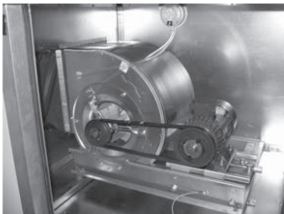
Рис. 20. Секция вентилятора с клиноременной передачей
