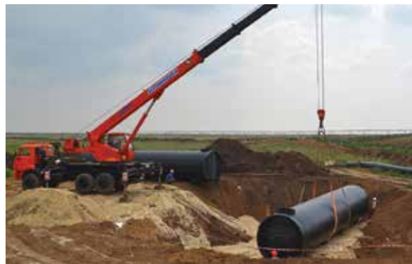
Накопительные резервуары. Хутор Песковатка, Волгоградская область, строительство оросительной системы.
