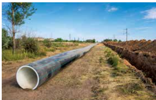
Строительство комплекса по производству овощей, г. Волжский, 2018 г.
