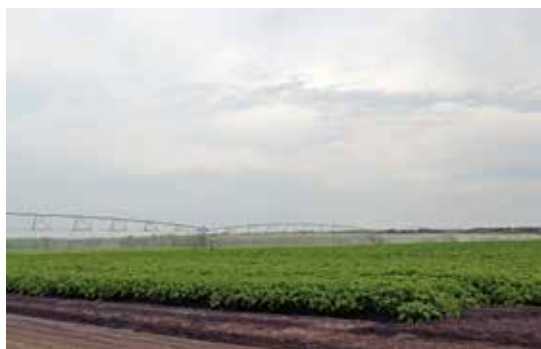
Строительство систем орошения для КФХ Кшыш А.А. Омская обл., 2022 г.
