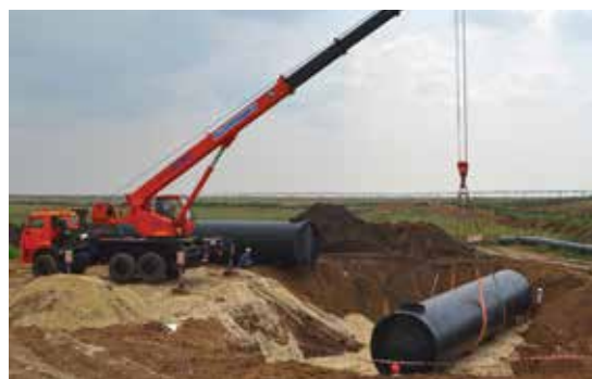
Строительство системы орошения, х. Песковатка, Волгоградская обл., Городищенский р-н., 2016 г.
