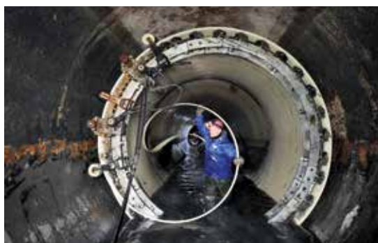
Санация канализационного коллектора профилем СПИРАТЕХ, г. Иваново
