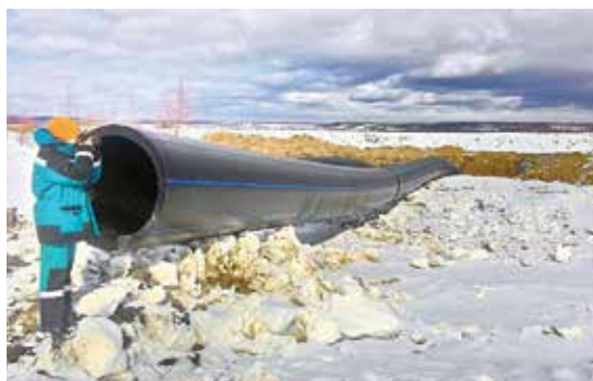
Строительство «Епанчинского водозабора». Комплекс «ЗапСибНефтехим», г. Тобольск
