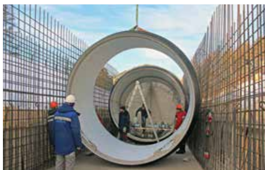
Строительство Акуловского закрытого канала водоохранной зоны, г. Москва
