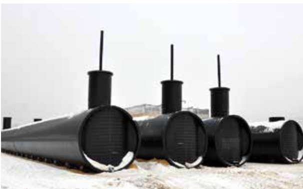
Комплекс резервуаров (400 м 3 ) для хранения воды хозяйственно-питьевого назначения. Микрорайон Новоугольный Тульской области, строительство водозаборного узла.
