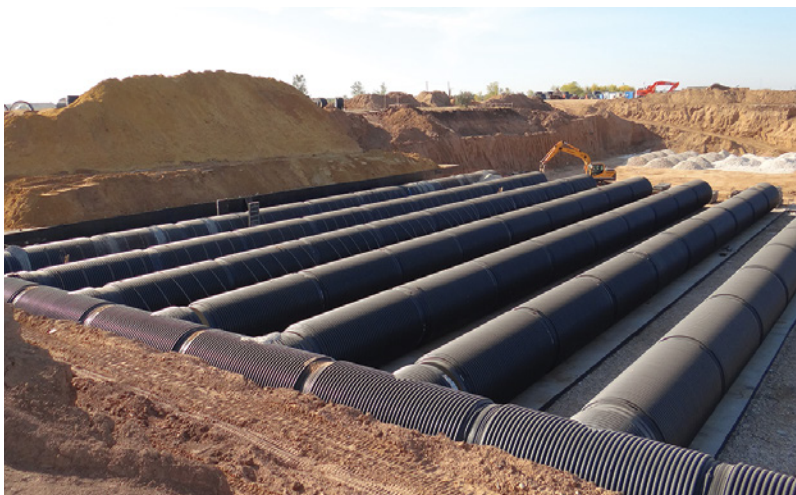
Аккумулирующий резервуар, г. Энгельс, Саратовская область, реконструкция аэродрома.
