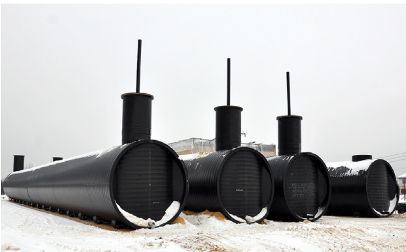
Комплекс резервуаров (400 м 3 ) для хранения воды хозяйственно- питьевого назначения. Микрорайон Новоугольный Тульской области, строительство водозаборного узла.
