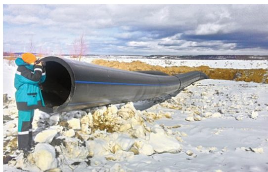
Строительство «Епанчинского водозабора». Комплекс «ЗапСибНефтехим», г. Тобольск
