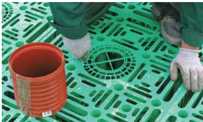
Удаление узорной решетки на отверстии диаметром OD 200 мм, расположенном в верхней части блока
