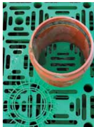
Соединение раструбного перехода диаметром 200 мм с верхней стенкой блока
