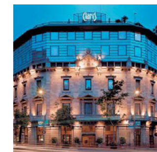
Переоборудование отеля Hotel Claris 5* Барселона, Испания ECOi
