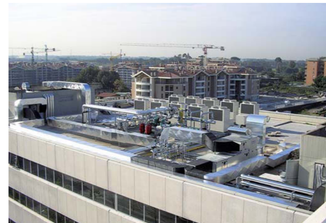
Замена чиллера. Подача холодной воды к фанкойлам.
