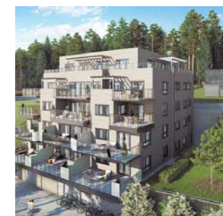
Новый кондоминиум Berges Terrasse Complex Драммен, Норвегия ECOi /Aquagea
