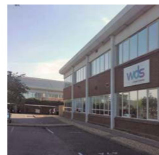
Реконструкция call-центра Woodhouse Environmental Services Ltd., Борнмут, Великобритания VRF
