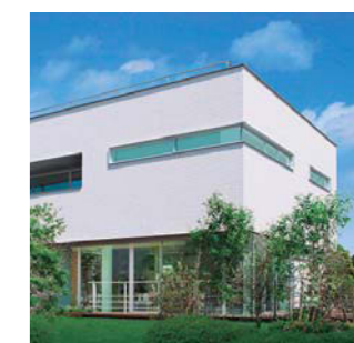
«Умный дом» Ариаке, Токио HVAC и комбинация генераторов солнечной энергии, батарей и аккумуляторов
