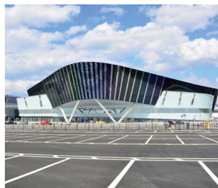
Конгресс-Холл, Екатеринбург-ЭКСПО, г. Екатеринбург
