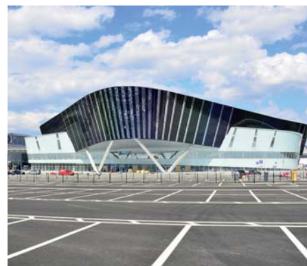
Конгресс-Холл, Екатеринбург-ЭКСПО, г. Екатеринбург
