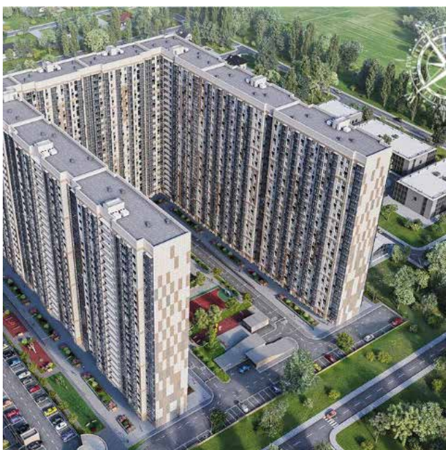
Город: Ростов-на-Дону Название объекта: ЖК West Side
