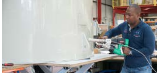
FUSION 3C при сварке углового шва
