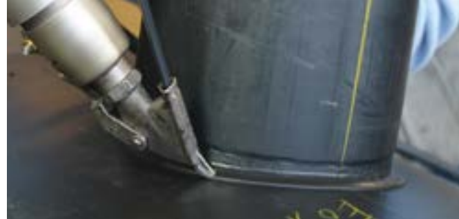
Сварка комбинированной насадкой
