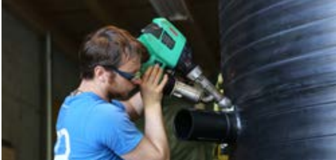
Удобный WELDPLAST S2 в работе
