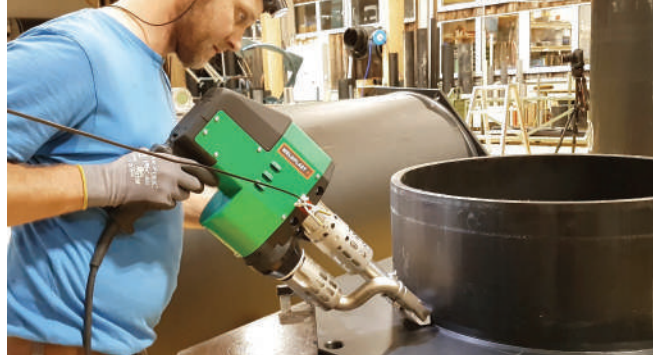
Мощный WELDPLAST S4 в работе
