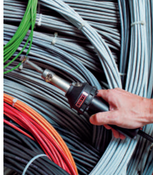
HOT JET S с решётчатой рефлекторной насадкой при установке термоусадочной муфты
