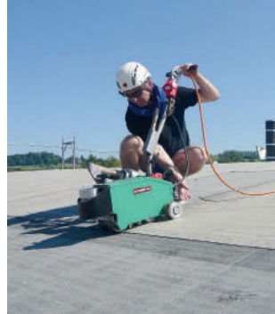
Простое управление и чистая сварка при использовании BITUMAT B2
