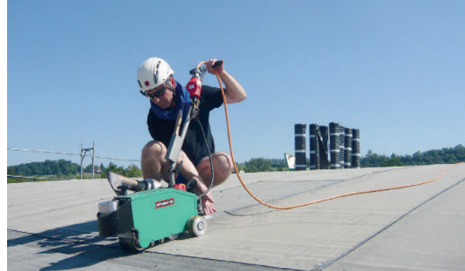
BITUMAT B2 безупречно сваривает эластомерный битум
