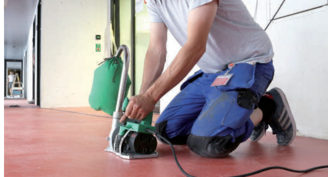
Мощный привод GROOVER подходит для ПВХ, ПУ и линолеума
