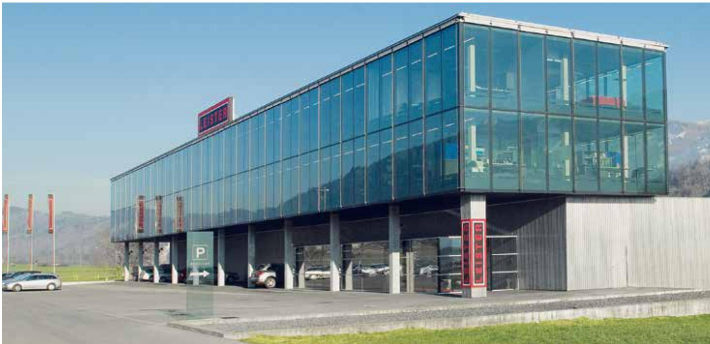
Leister Technologies AG, корпоративный центр, Кегисвиль, Швейцария
