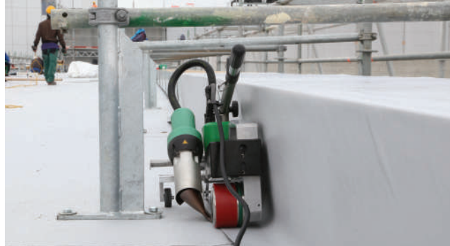
Автоматическая сварочная машина UNIROOF без проблем сваривает все труднодоступные места на кровле
