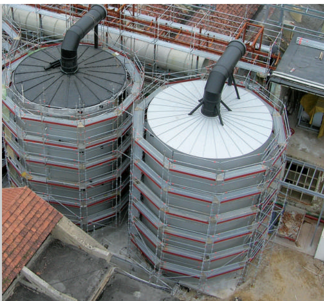
Система очистки воздуха, Испания. Материал ПЭНД
