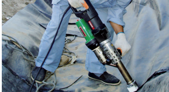
Благодаря своей длине экструдер FUSION 3 особенно подходит для использования в области подземного строительства
