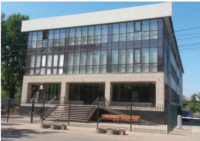
КОЛЛ-ЦЕНТР «ТЕЛЕ2» Иркутск, 300 квТ
