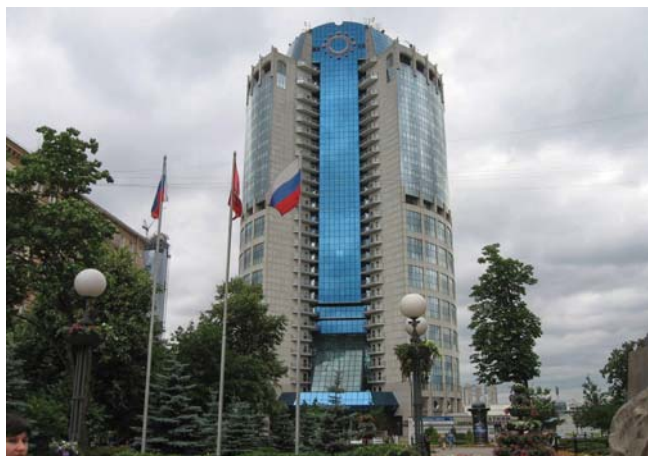
ГУП «МОСВОДОСТОК» Москва, 440 кВт
