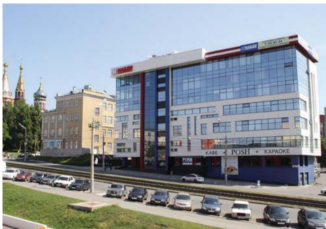
БИЗНЕС-ЦЕНТР «НАЙДИ» Ижевск, 498 кВт
