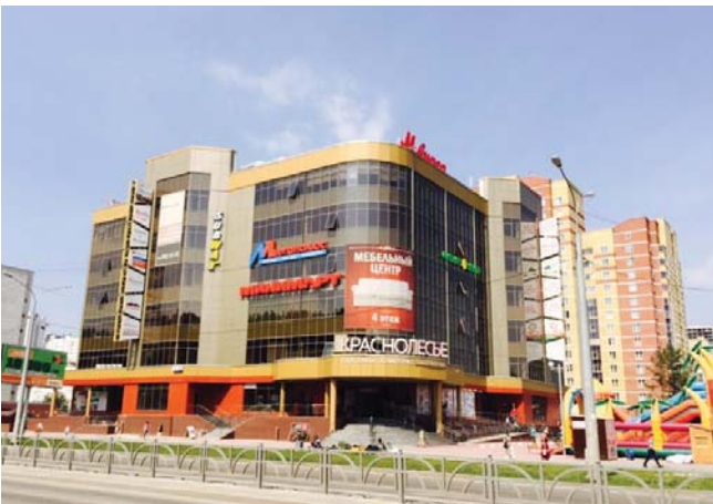
ТОРГОВЫЙ ЦЕНТР «КРАСНОЛЕСЬЕ» Екатеринбург, 700 квТ
