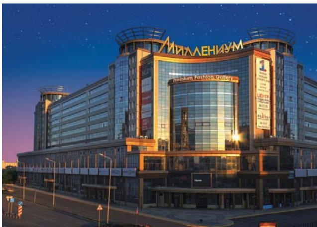
ТОРГОВЫЙ ЦЕНТР «МИЛЛЕНИУМ» Омск, 410 кВт
