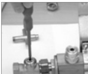
Рис. 37. Выполнение настройки на обратном вентиле
