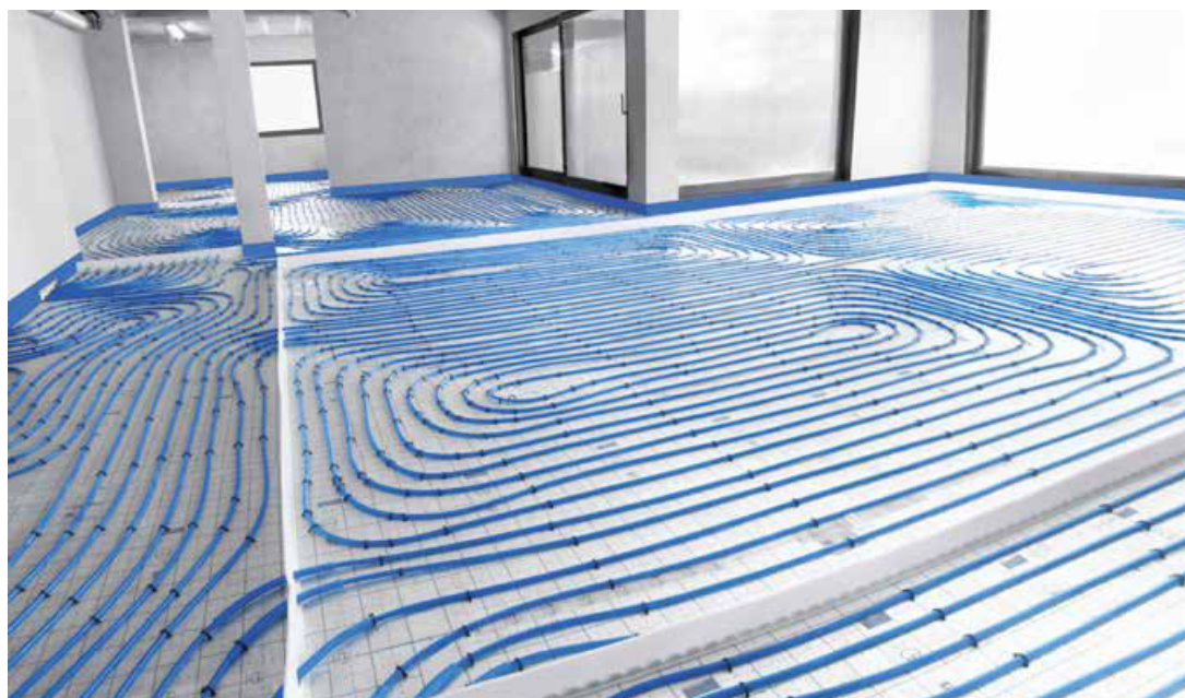
Рис. 25. Напольное отопление/охлаждение, выполненное в системе KAN-therm Tacker
