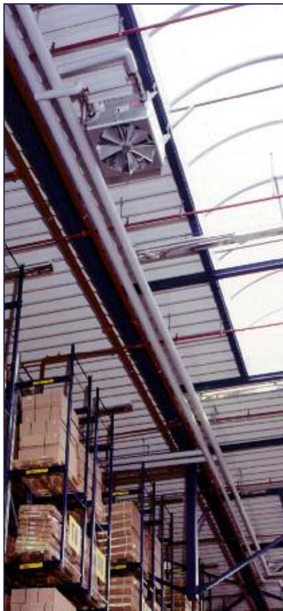
Теплообменник из оцинкованной стали, поперечноточный
