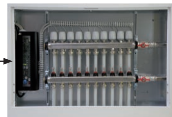
Установка зонного модулю в шафі опалювального контуру
