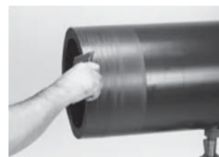
Фото 2.2. Снятие фаски для облегчения надевания муфты
