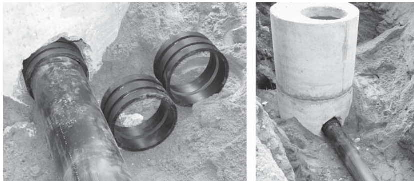
Фото 2.1. Защитные муфты для входа в бетонный колодец
