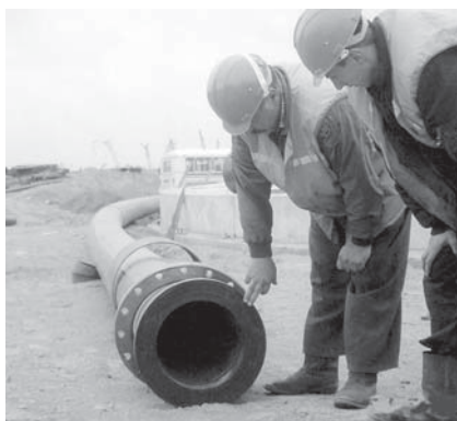
Фото 1.4. Разъемное фланцевое соединение ПЭ труб
