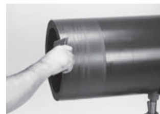
Фото 4.2.6. Снятие фаски для облегчения надевания муфты
