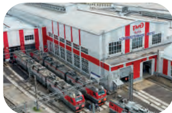
Ремонтное депо РЖД, г. Чита
