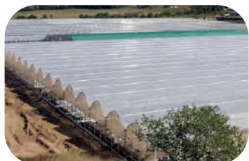
Теплицы СХП Кавказ, Ставропольский край
