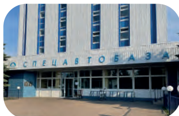
ГУП Водоканал, г. Санкт-Петербург
