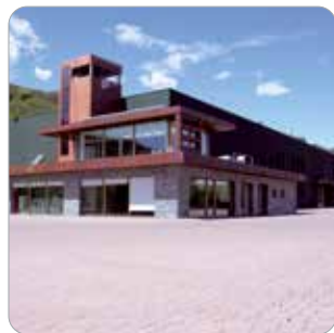
NEW PRODUCTION UNIT San Maurizio d'Opaglio (NO)
