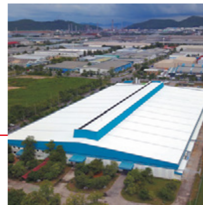
Fujitsu General (Thailand) Co., Ltd., второй завод
