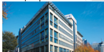
R&D центр Fujitsu General (EURO) GmbH (Германия)
