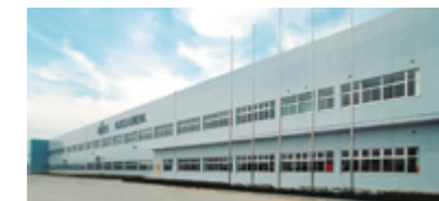
Fujitsu General Central Air-conditioner (Уси) Co., Ltd. (Китай)
