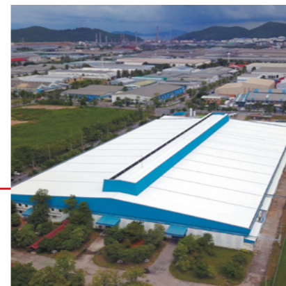
Fujitsu General (Thailand) Co., Ltd., второй завод
