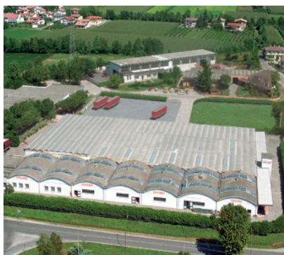
Учебный центр, производство лучистых теплообменников Training center, production of radiant heat exchangers
