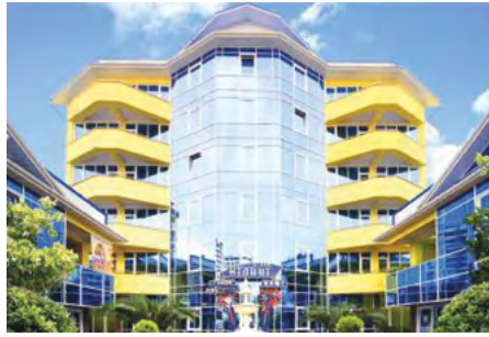
Объект: Гостиница «Атлант», г. Сочи Поставщик: ООО «Теплосервис»
