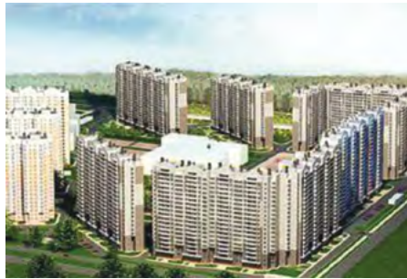
Объект: ЖК «Каменка», г. Санкт-Петербург Поставщик: ООО «Денеб»
