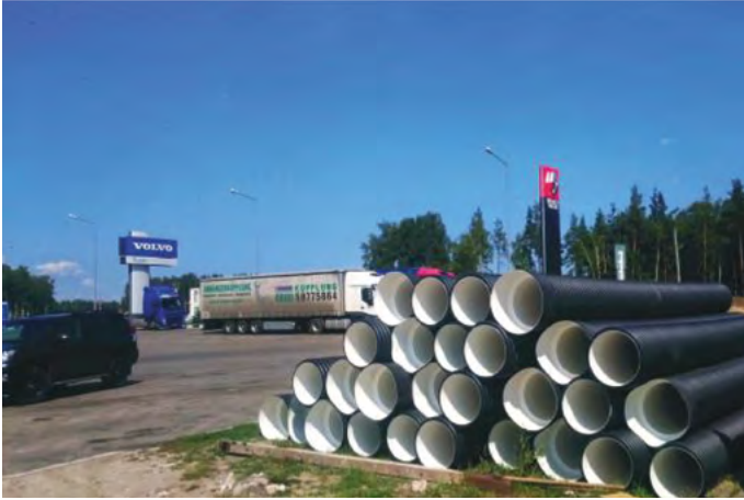
Объект: Прокладка ливневой канализации, г. Дзержинск Подрядчик: ООО «ТД Пласт Сервис»
