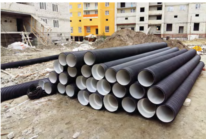
Объект: Жилой комплекс мкр. Среда, г. Пенза Подрядчик: ООО «РУСКОМПЛЕКТ»
