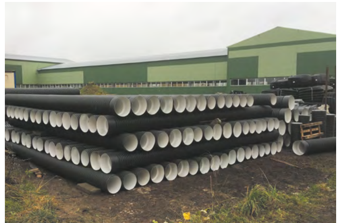
Объект: Строительство коровника, г. Вологда Подрядчик: ООО «Электроспутник» ТД АГРО
