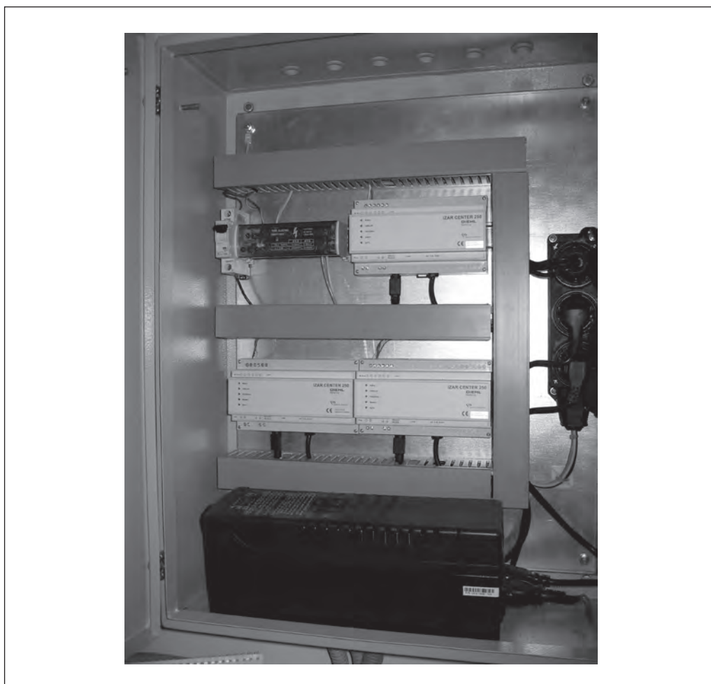
Пример монтажа концентраторов Izar Center
