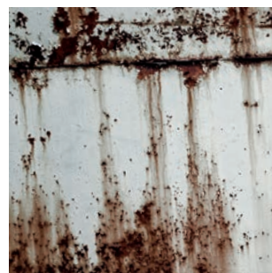
Защита от образования ржавчины и коррозии
