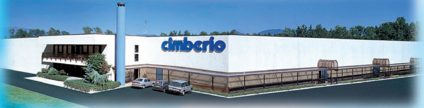
Berzonno di Poggio plant
