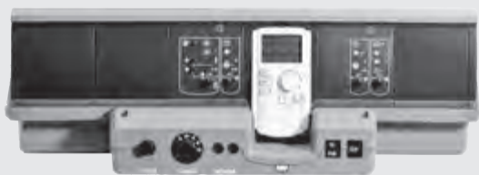
Logamatic 4324 с блоком управления MEC2H 1)
